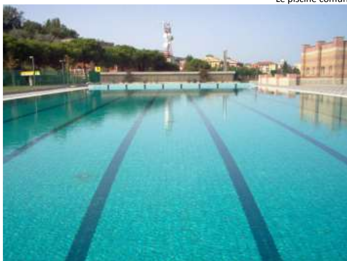
Impianto natatorio scoperto con vasca olimpionica da 50 x 18 mt., profondità 1,90 mt da suddividere in 2 campi gara da 25 x 18 mt
